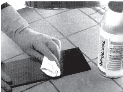
Abb. 13: Chemisches Nachbehandeln einer vorgeschliffenen Oberfläche
